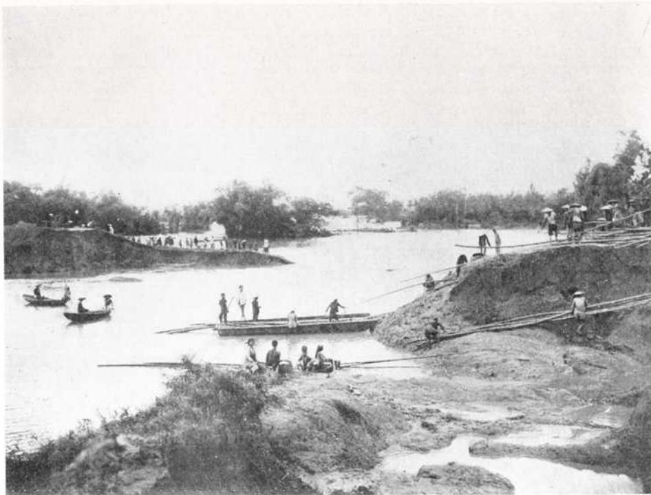
BRÈCHE APRÈS L'INONDATION DU CASIER
