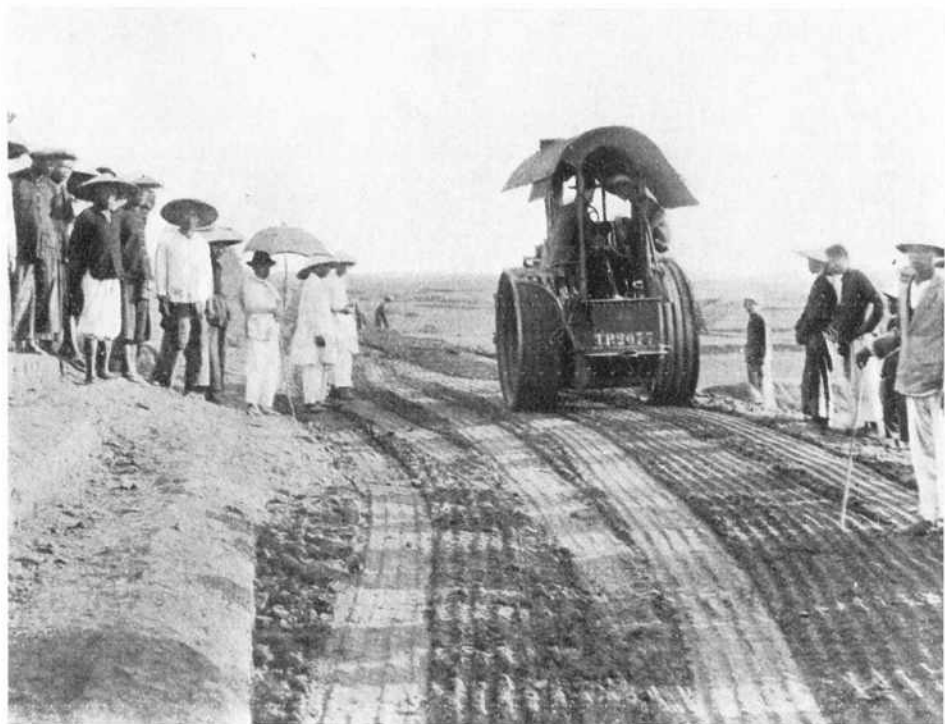
EXÉCUTION DE MASQUES CORRUYÉS Emploi de rouleaux à vapeur
