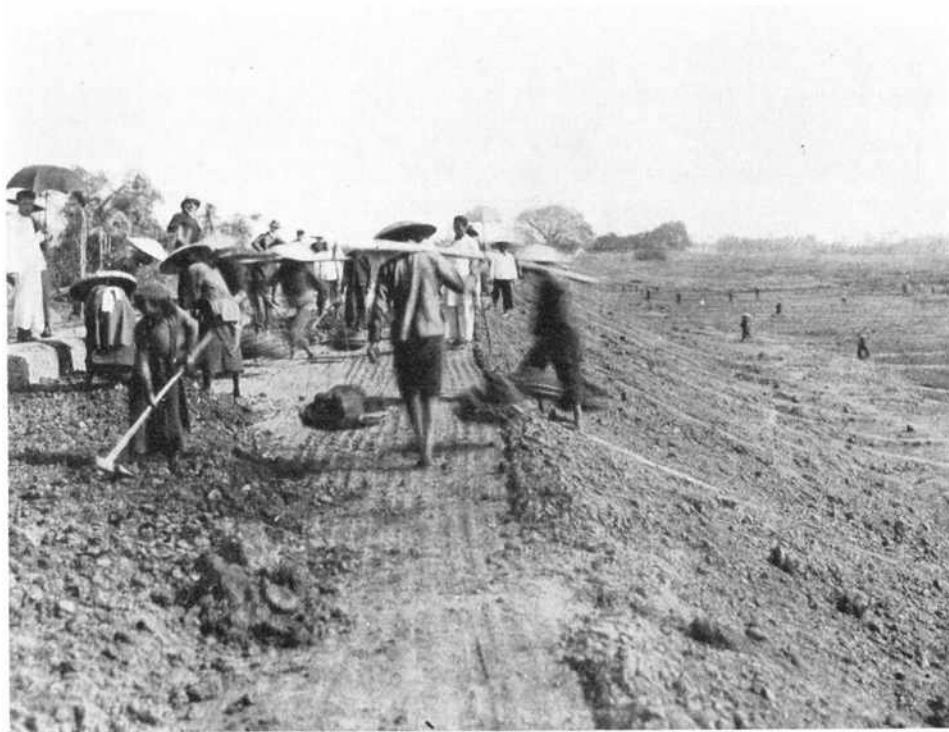
EXÉCUTION DE MASQUES COÛBOYÉS Répandage et piochage des terres
