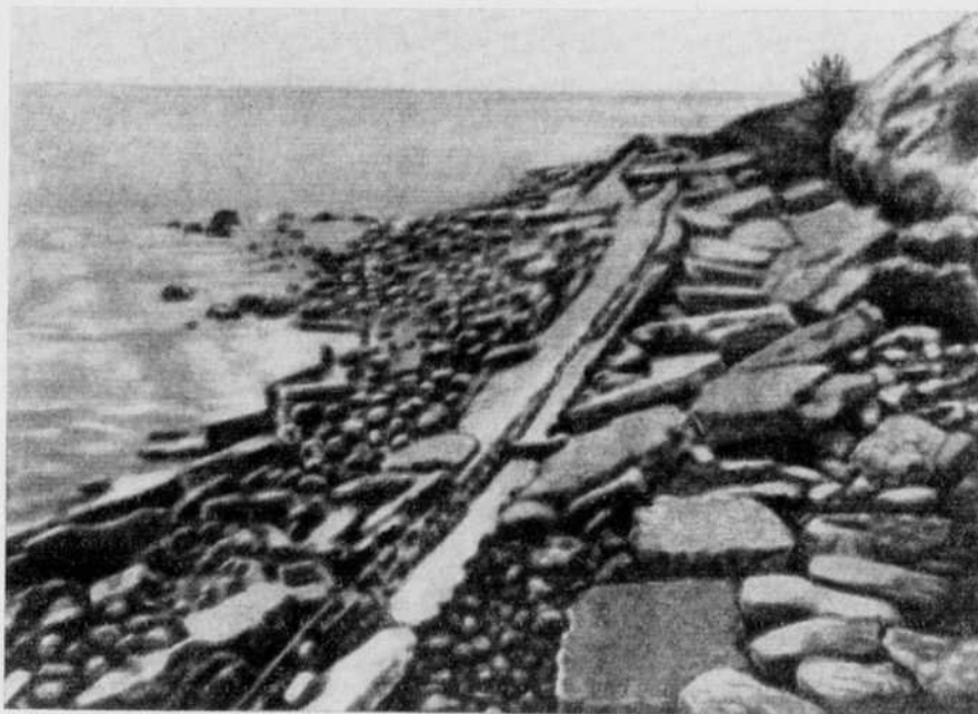
H. 254 Đê biển bảo vệ trên đảo Uzédôm (biển Bantich) bị phá hủy trong trận cuồng phong tháng chạp năm 1913 — tháng giêng năm 1914
